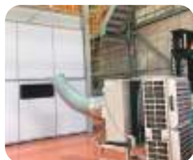
高所作業場 (住友重機械モダン様)
