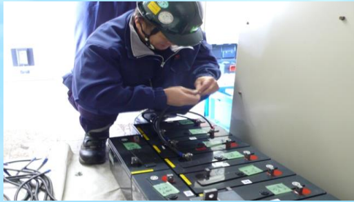
仮設電池搬入切替
