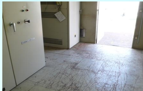
復旧完了：清掃完了
