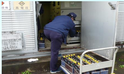
処置電池搬入設置
